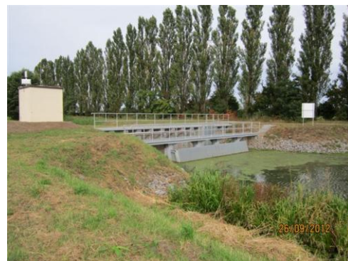
Stauanlage mit Schöpfwerksgebäude
