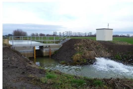
Stauanlage mit Schöpfwerksgebäude
