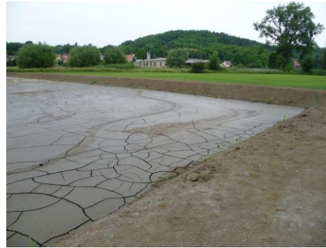
Spülbecken mit Schlammablagerungen
