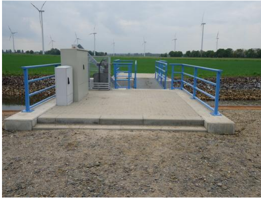
Wehranlage Bochows Loos
