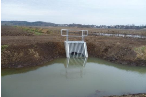
Durchlass Altglietzer Hauptgraben
