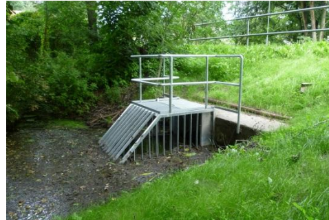
Durchlass Worin, Lechnitz
